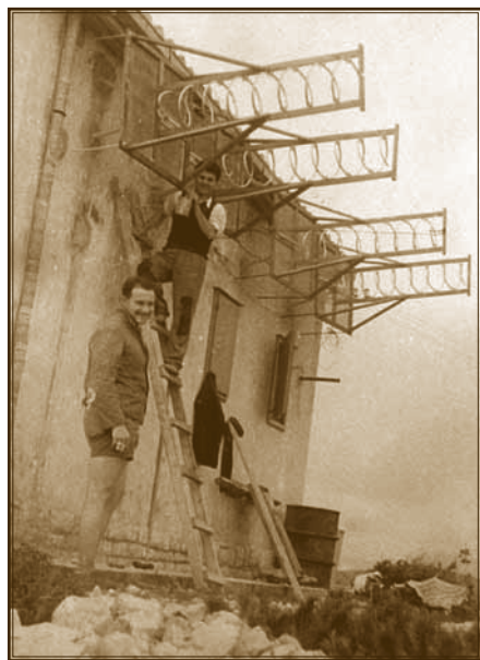
Montaža anten na Klisu (Split)
